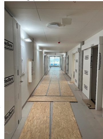
Færdigmonterede loftpaneler i KBA-området
