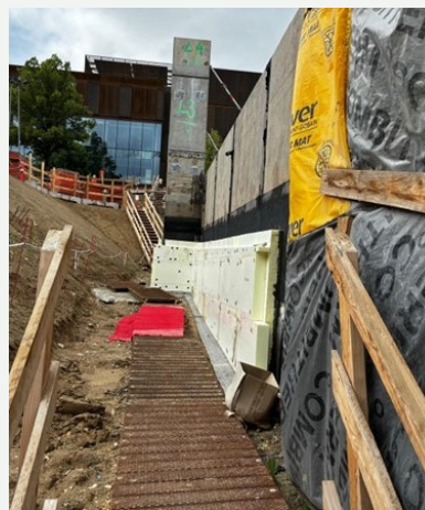
Vest tunnel – Membran og isolering
