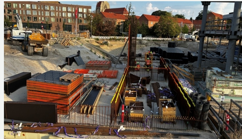
Forberedte fundamenter og vægge ved tårn 75
