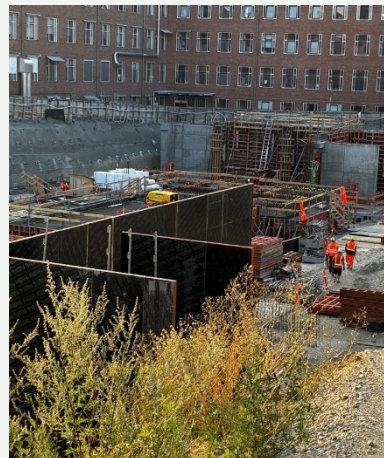
Forberedte vægge ved B73 og B71
