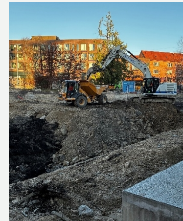
Nedsivningsanlæg - udgravning
