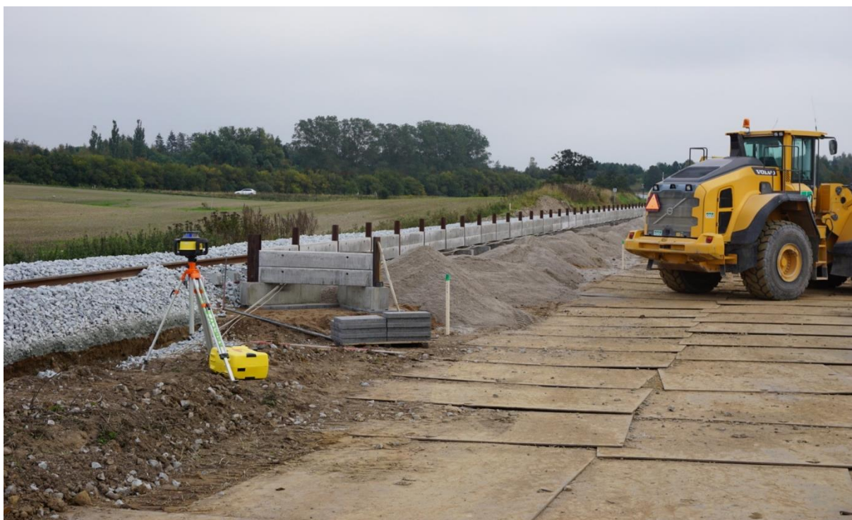
Forberedende arbejde ved Troldebakkerne, 26. september 2019
