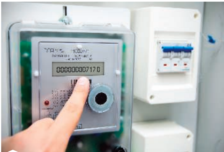
Der er styr på forbruget, så tælleren ikke løber løbsk.
