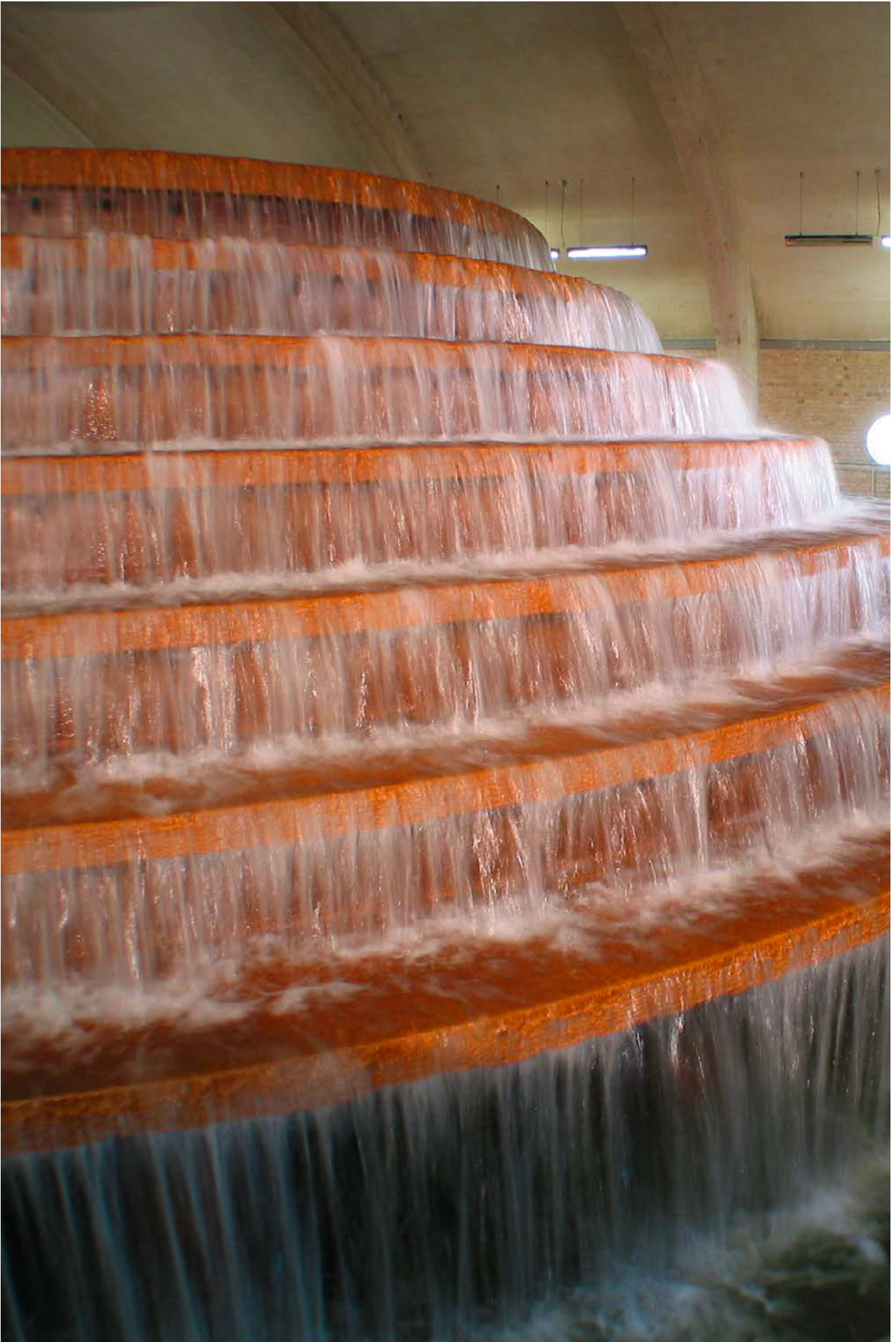
Simple vandbehandling på et vandværk består i iltning og filtrering, der fjerner naturlige stoffer som jern og mangan fra vandet.
