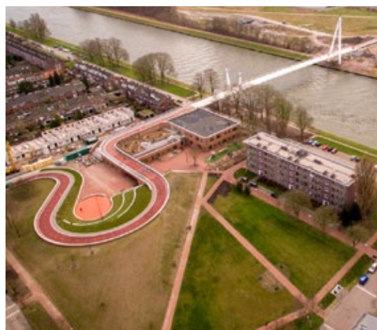
Cykelbro integreret i (over) skole i Utrecht.
