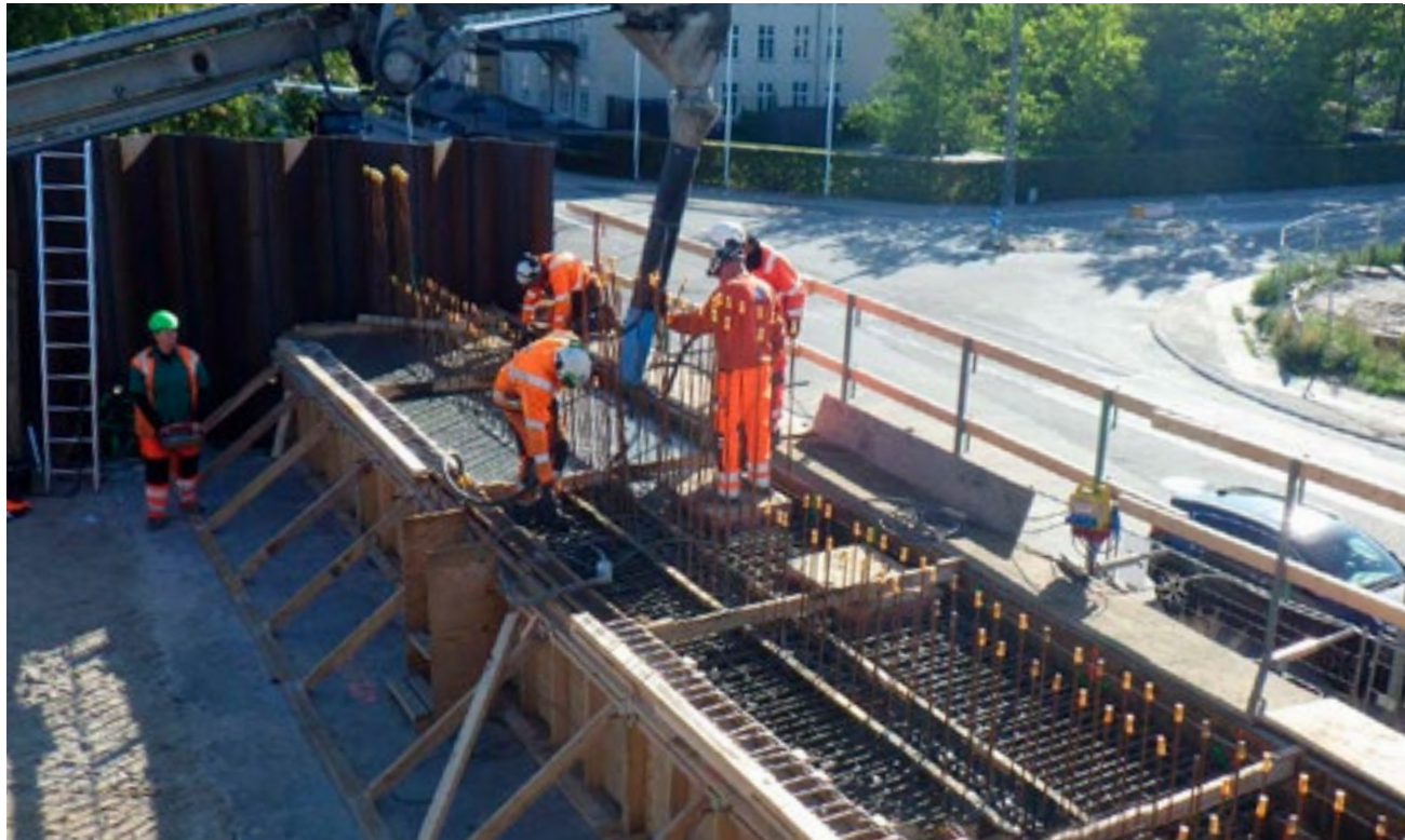
I 2020 har letbaneprojektet haft et stort fokus på sikkerhed. Det har resulteret i, at projektet per 31. december 2020 har haft 492 dage uden ulykker med fravær.
