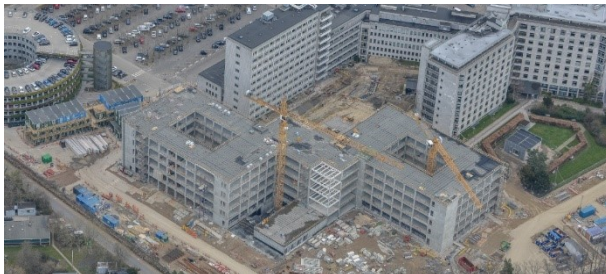
Figur 3 Luftfoto af byggeriet
