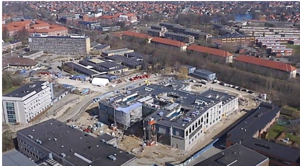
Figur 1 Luftfoto af byggeriet
