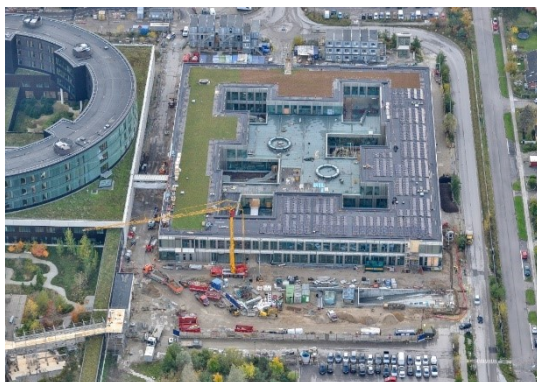
Figur 7 Luftfoto af byggeriet
