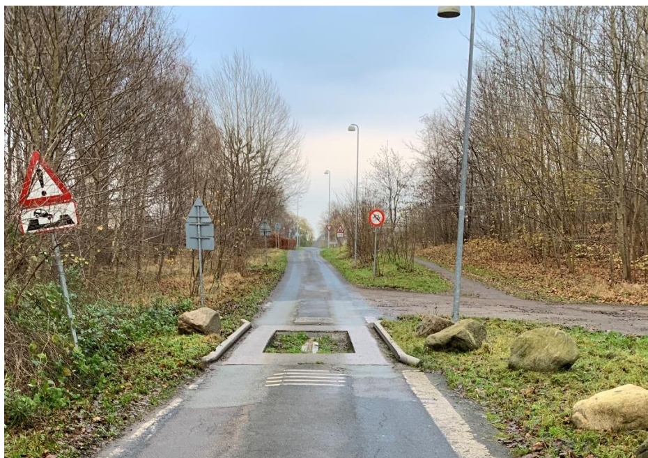
Figur 2.4 foto af eksisterende bussluse ved Højager.
