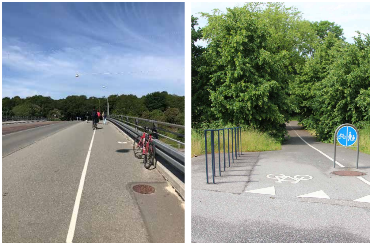
Figur 9: Adgangsforbindelser, der fremstår isolerede, tæt beplantede eller dårligt oplyst, opleves af mange passagerer som særligt utryghedsskabende.
