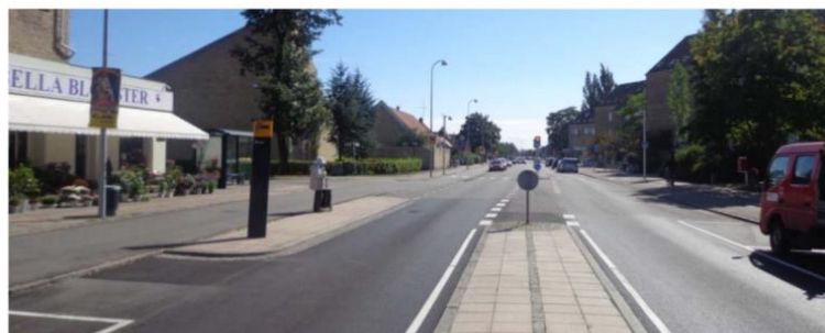
Figur 12 Eksempel på fremrykket busstoppested kombineret med midterhelle, der forhindrer overholing. (Kilde: Vejregelhåndbog: "Kollektiv bustrafik og BRT", juni 2016)
