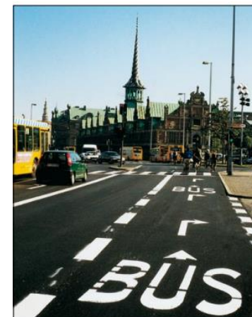
Bus- og højresvingsbane på Slotsholmen
