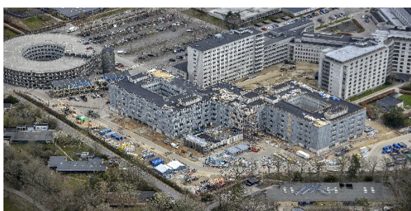
Figur 3 Luftfoto af byggeriet, april 2022
