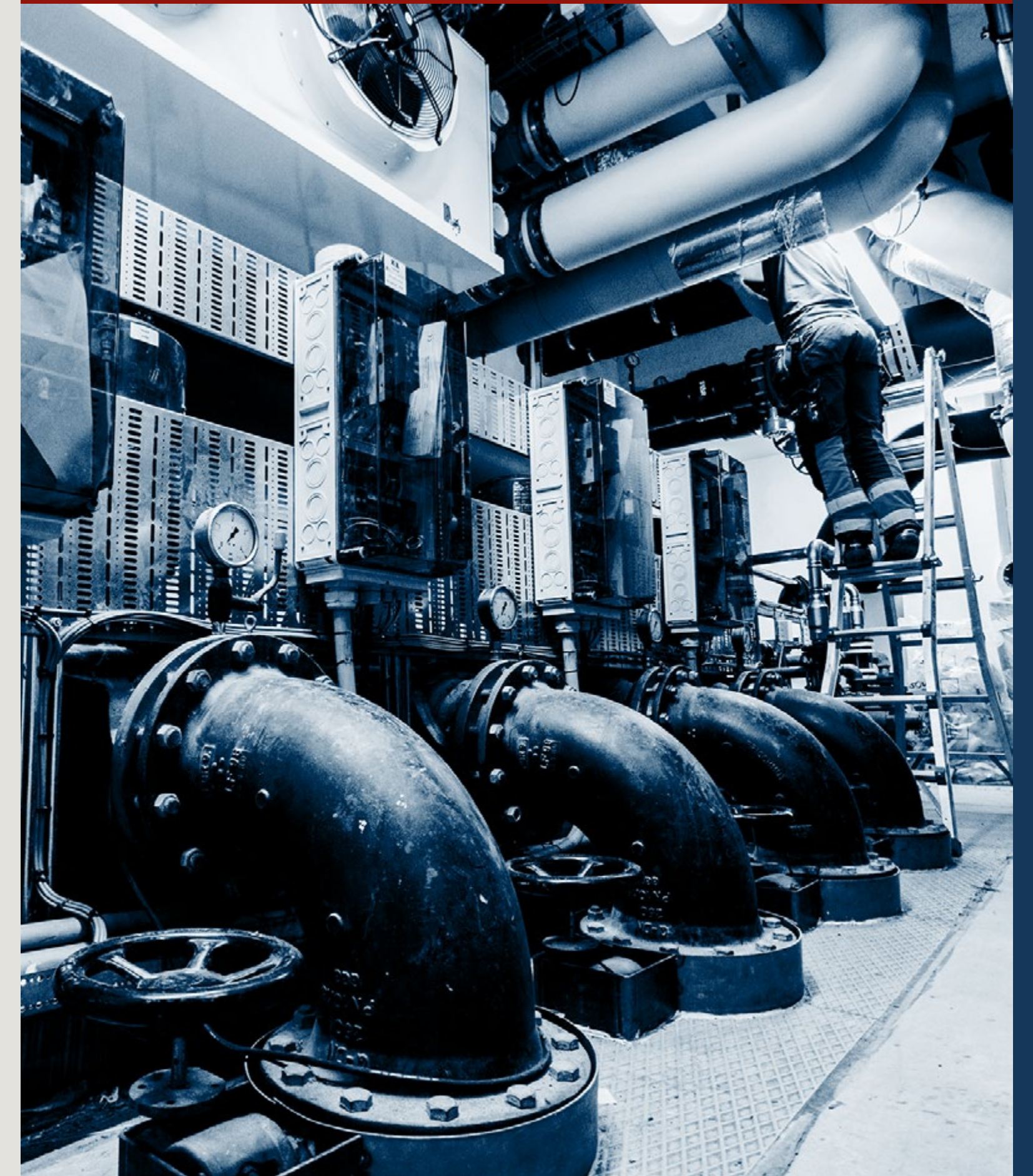
EN DEL AF DET NYE KØLESYSTEM UNDER INSTALLATION → FOTO: KEMP & LAURITZEN.
