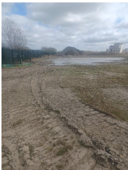
Billede 3. Tilsyn d. 10. april 2024 – Overfladevand i nordvestlige side af byggepladsen.
