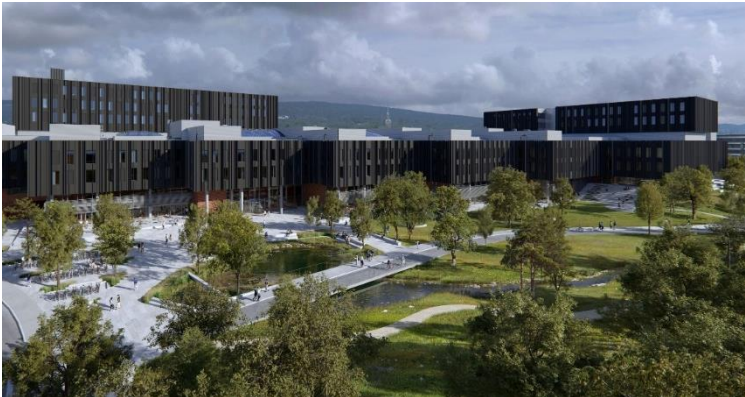
OUS i Livsvitenskapsbygget 2026
