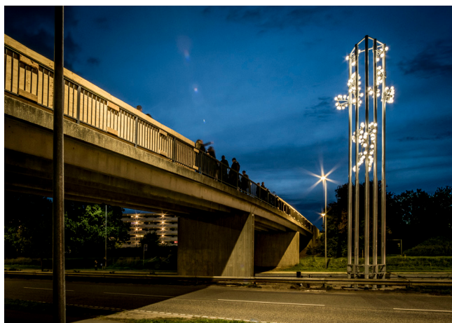
En markant bro. Lysværket ved Vallensbæk Station er et pejlemærke for biler og fodgængere og skaber tryghed i byrummet. Mogens Jacobsen, Gænger , 2018. Foto: Vallensbæk Kommune
