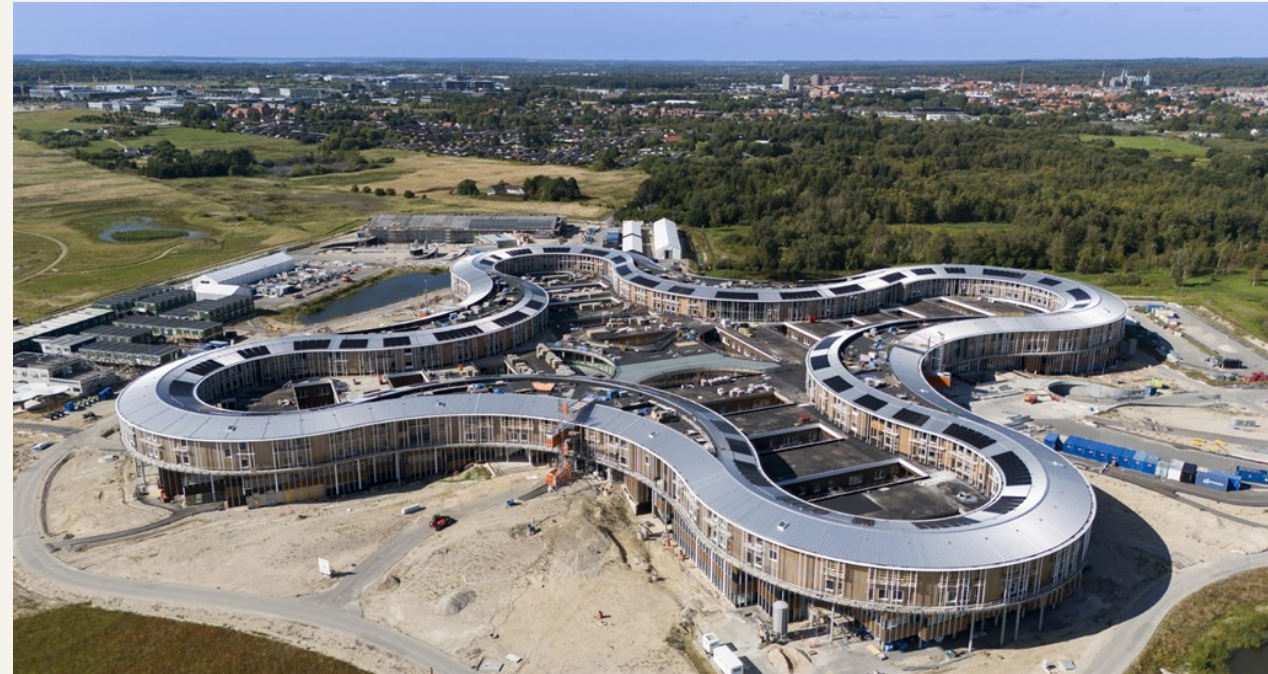
Luftfoto af byggeriet af Nyt Hospital Nordsjælland, foto: Jonatan Grevsen, NCC.
