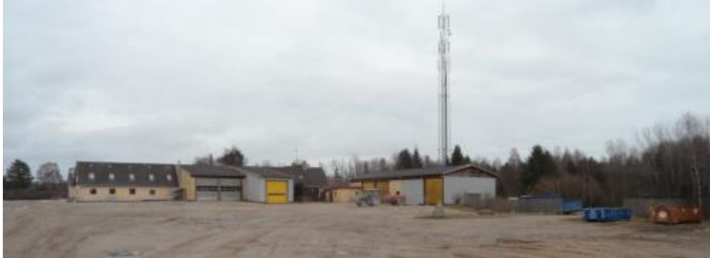
Del af serviceområde med kontor og mandskabsfaciliteter til venstre, garageanlæg i midten, og lager samt værkstedshal under mast.
