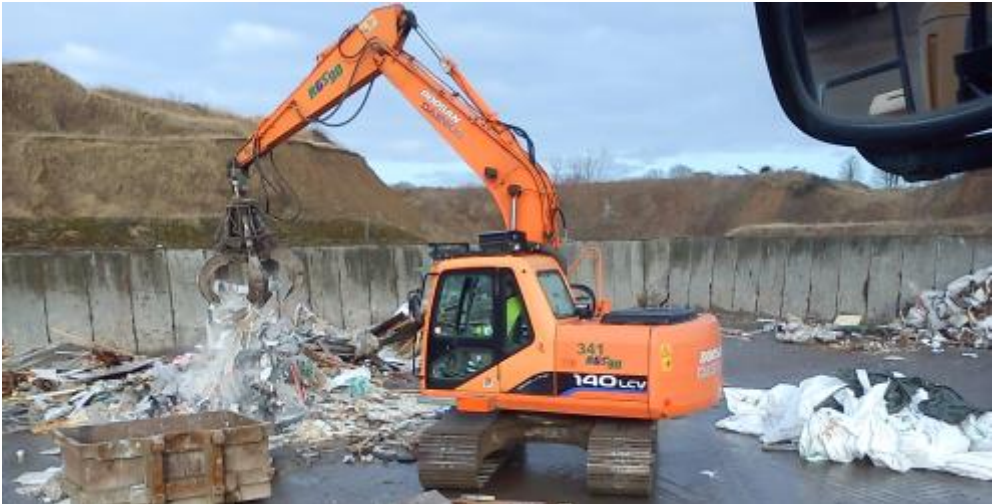
Gravemaskine i gang med sortering af erhvervsaffald.
