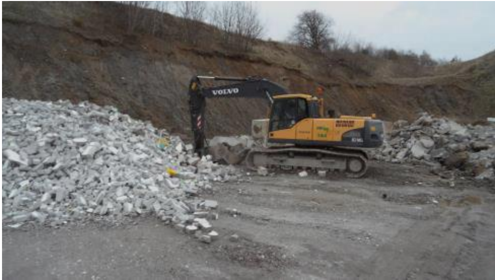
Større betonstykker klippes med betonsaks monteret på gravemaskine.
