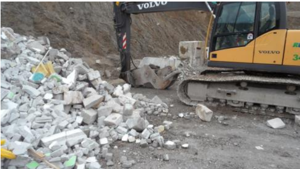
Betonsaks monteret på gravemaskine.
