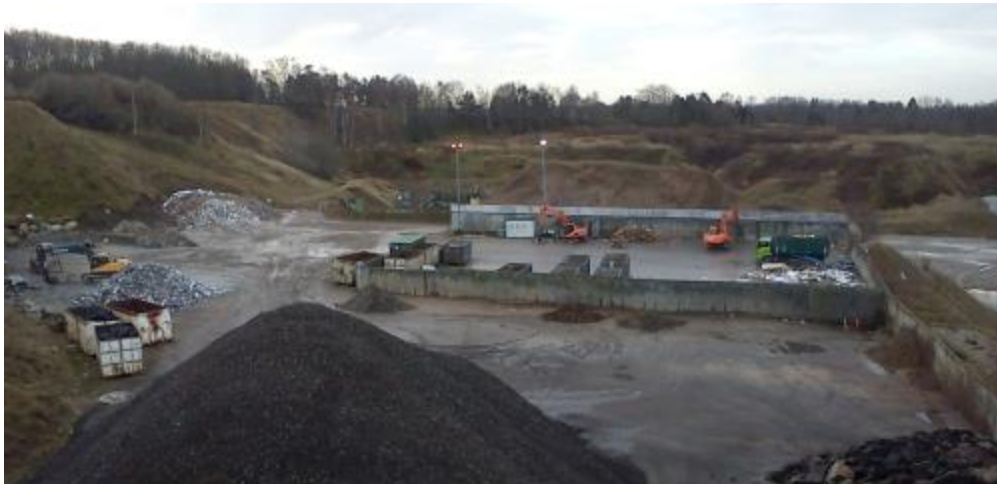
Område A med sorteringsplads indrammet af betonvægge og med asfalt- samt jordkarteringsplads forrest i billedet.
