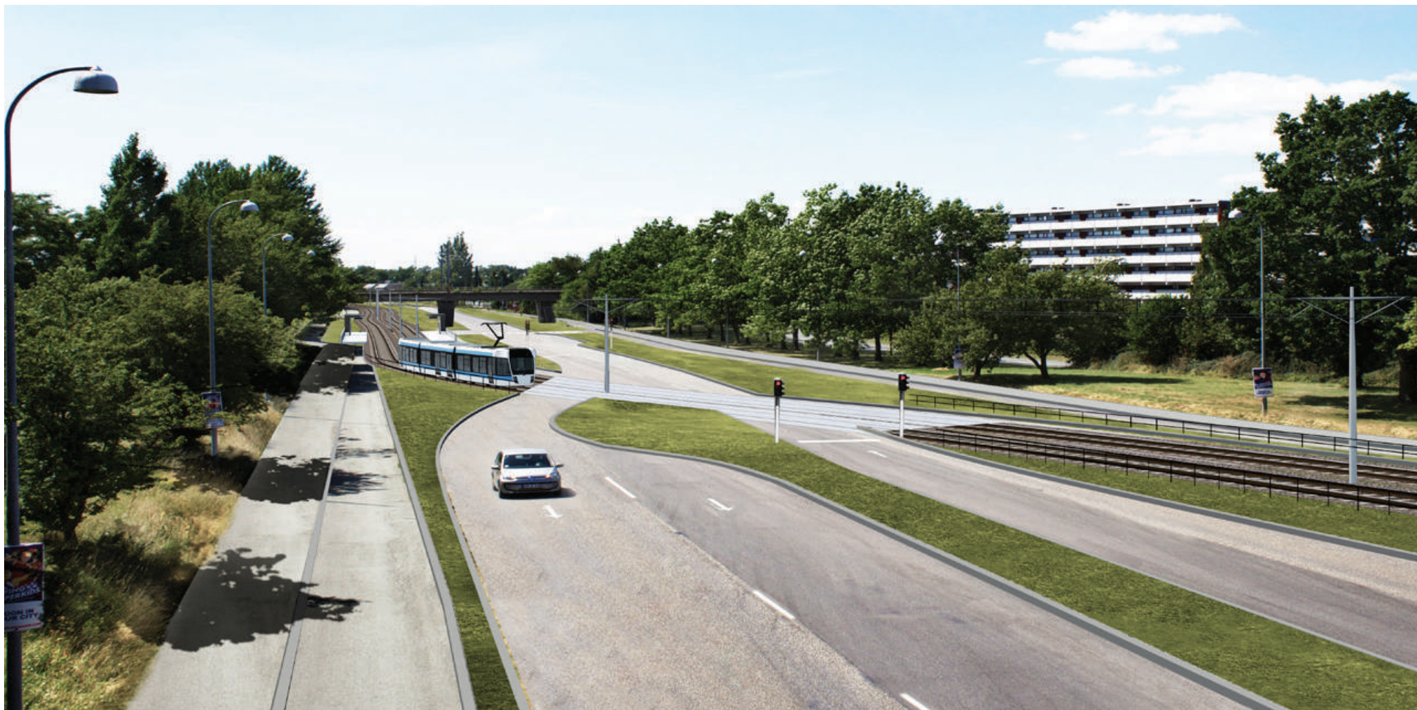
Station ved Vallensbæk S-station - sideperron
