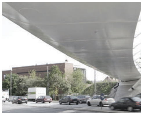
Underside i glat stål
