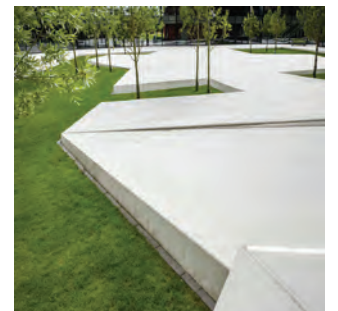
In situ støbt beton
