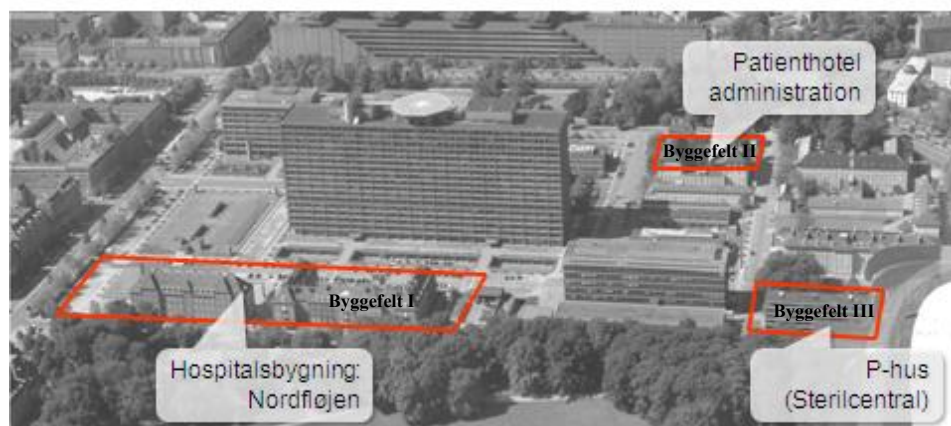
De tre byggerier, tilsammen Det nye Rigshospital udgør første del af en helhedsplan, der forholder sig til hele matriklen
