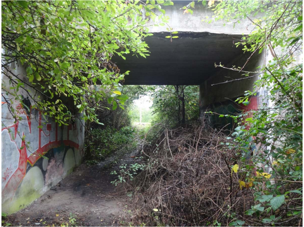
Figur 12. Eksisterende bro under Frederiksværkbanen
