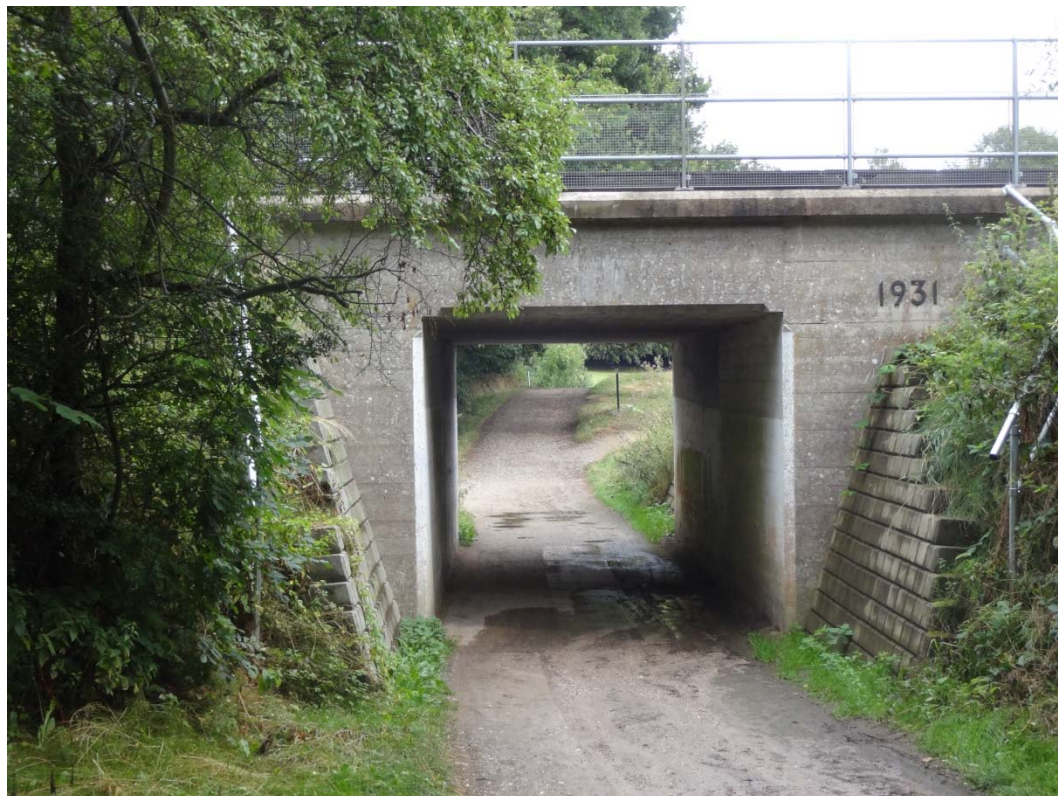
Figur 11. Eksisterende bro under S-banen.
