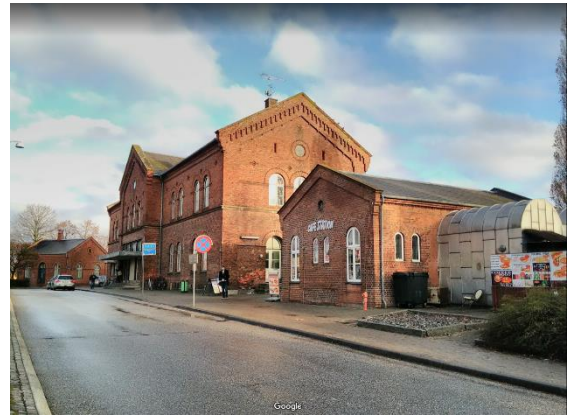
Stationsforpladsen, hvor stationsbygningen er under renovering.
