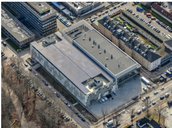
Figur 9 Foto af Sterilcentralen taget af Dragør Luftfoto
