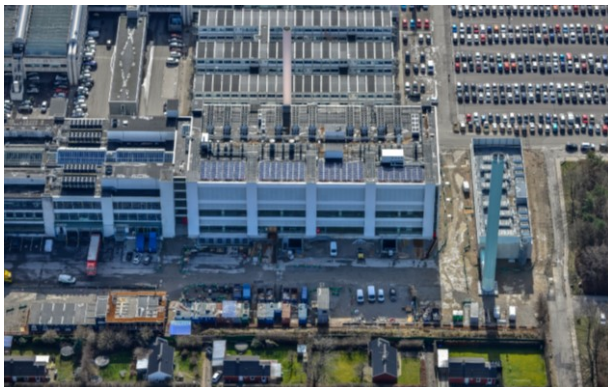
Figur 10 Foto af sterilcentralen taget af Dragør Luftfoto
