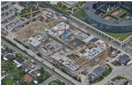
Figur 7 Foto af byggefelt for projektet taget af Dragør Luftfoto
