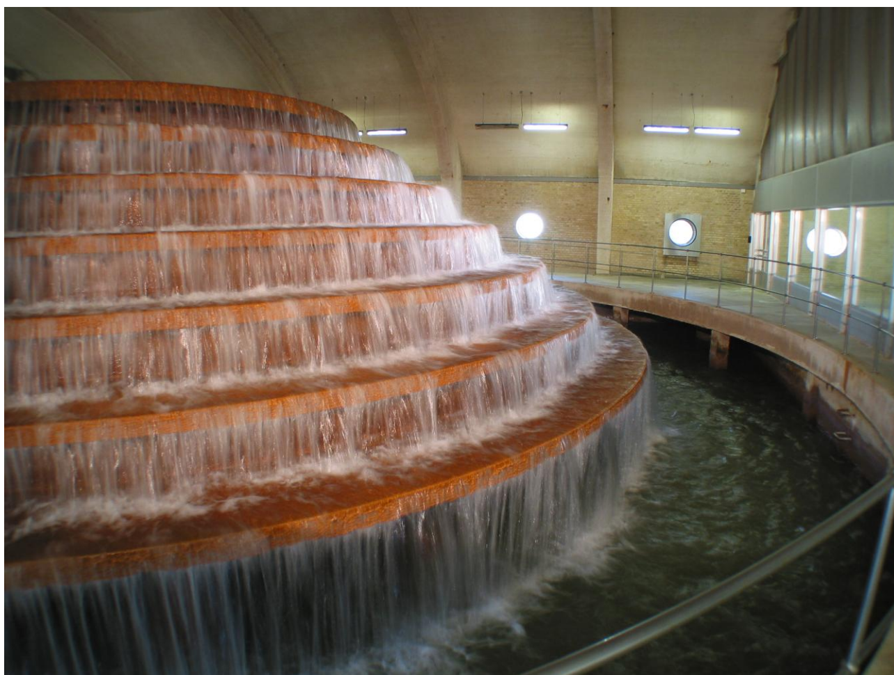
Drikkevandet i Danmark er baseret på rent grundvand. På vandværket skal grundvandet først iltes. Grundvandet indeholder nogle gange svovl-brinte, der lugter som rådne æg. Svovlbrinten fjernes ved at ilte vandet. Det sker ved, at vandet løber ud over en iltnings-trappe. Her damper svovl-brinten af. Vandet optager ilt fra luften, når det løber ned over iltnings-trappen. Det giver drikkevandet en frisk smag.
