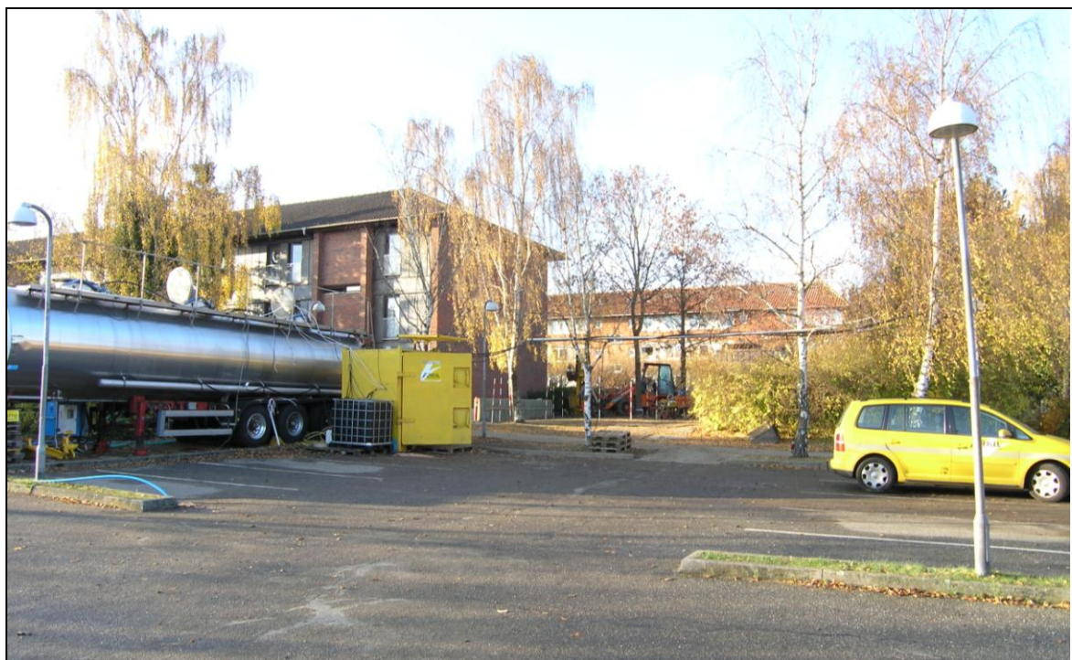
Oprensning af forurening med klorerede opløsningsmidler. Oprensningen sker ved at tilsætte organisk stof og bakterier til grundvandet. Bakterierne omdanner de skadelige klorerede opløsningsmidler til uskadelige stoffer. Det organiske stof fungerer som føde for bakterierne. Det organiske stof opbevares i tankvognen og pumpes derfra ned i grundvandet. Metoden kaldes "Stimuleret Reduktiv Deklorering".
