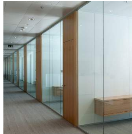
Glasvægge med massive døre og lukket felt over.
