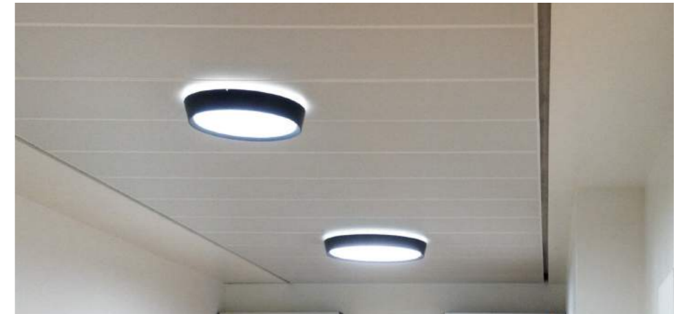
Metalloft korridor m/ gipsfrise
