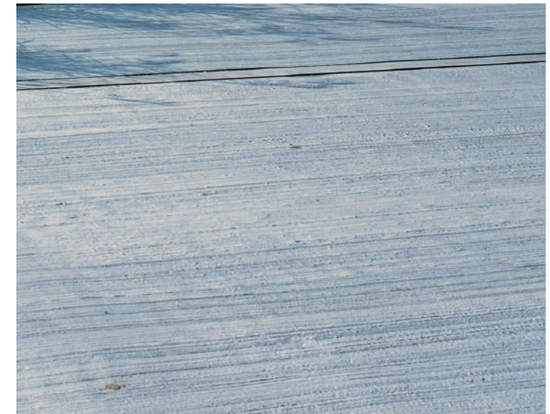
In situ kostet beton
