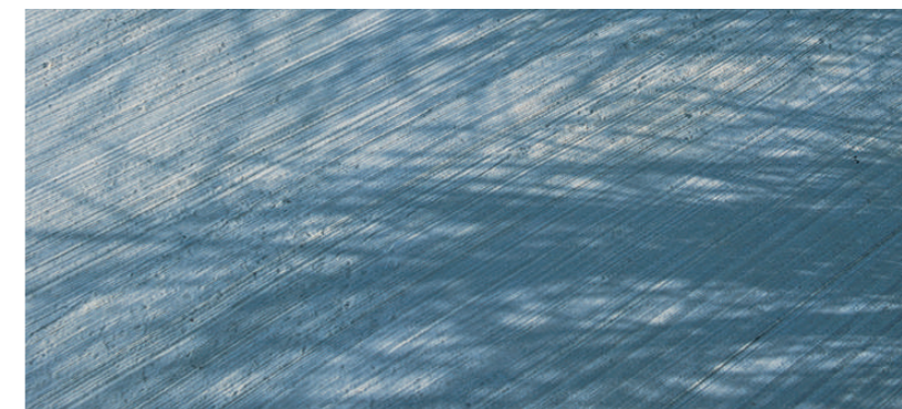
In situ kostet beton
