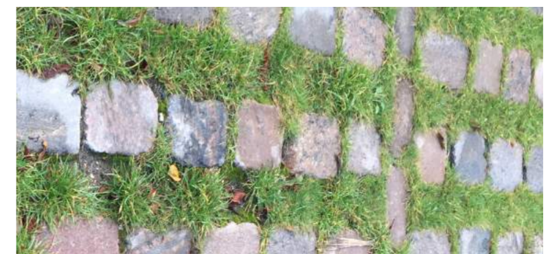
Brandvej, brosten med brede græsfuger
