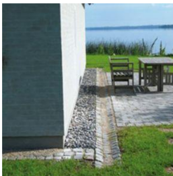
Figur 15 - Skærver lagt i beton giver et udseende som stenbed. Yderligere ses en åben vandrende.
