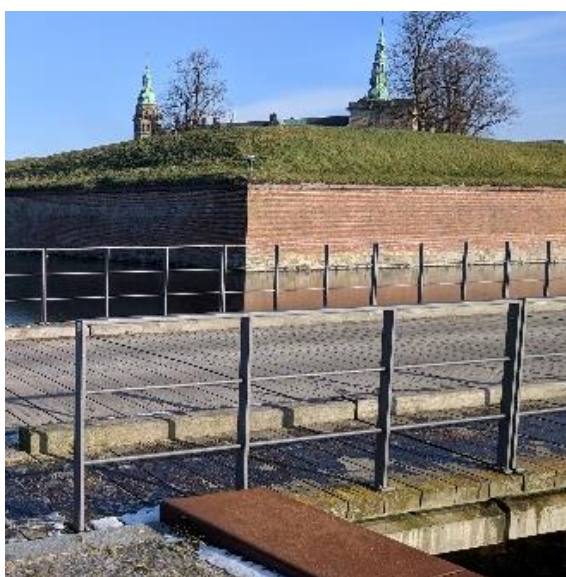
Figur 12 - Værn ved broen til Kronborg, ved Søfartsmuseet.
