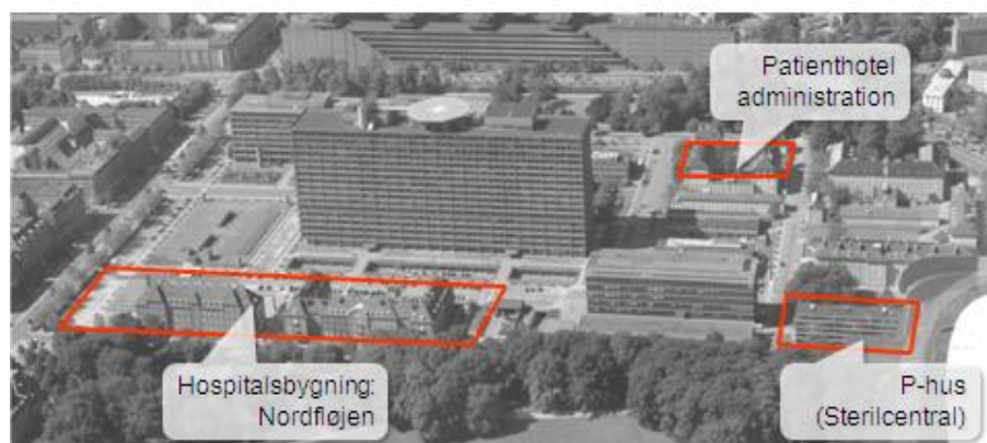
De tre bygninger, tilsammen Det nye Rigshospital udgør første del af en helhedsplan, der forholder sig til hele metrikken
